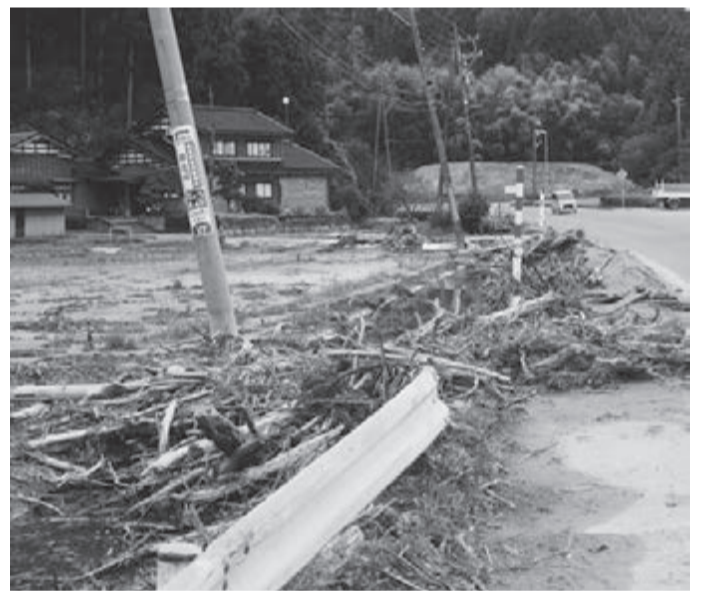
水害により流れてきた流木=現在の写真
