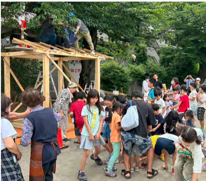
多いに盛り上がった上棟式の様子＝北浦公園にて
